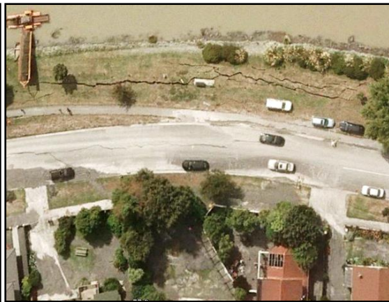
(d) Severe Lateral Spreading
