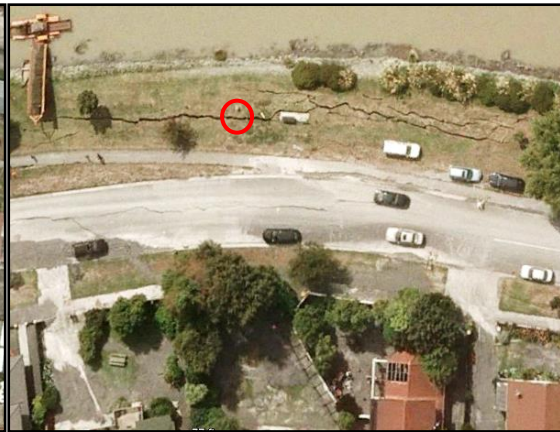
(d) Severe Lateral Spreading
