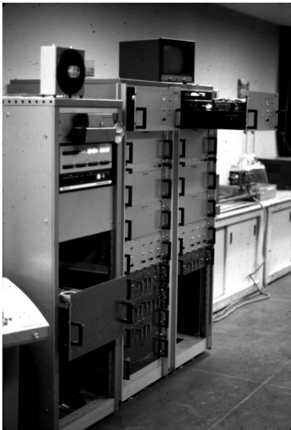
Илл. 21: Конфигурируемая (со съёмными модулями и съёмными крейтами) конфигурация Multi 8 d'Intertechnique (1972).
