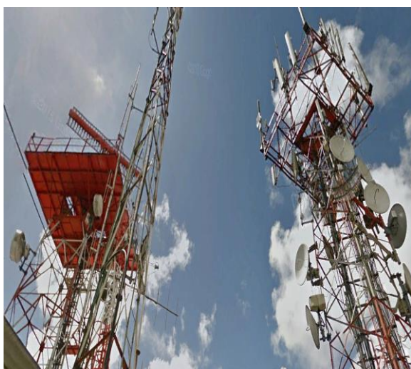
Figura 2. Estación Aeronáutica Cerro Verde - Aerocivil.
