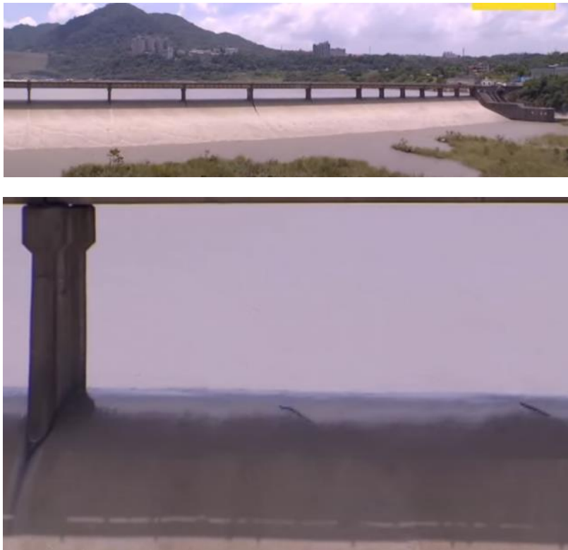
(a) 石门水库侧堰取水方式
