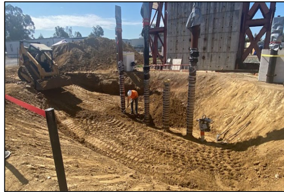
(d) Backfill Soil Pit – Day 1
